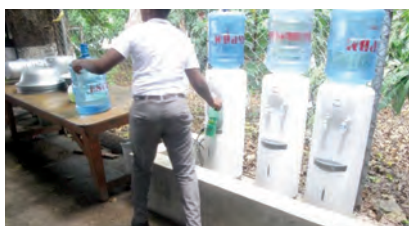
Distribution de l'eau potable en libre-service près de la restauration
